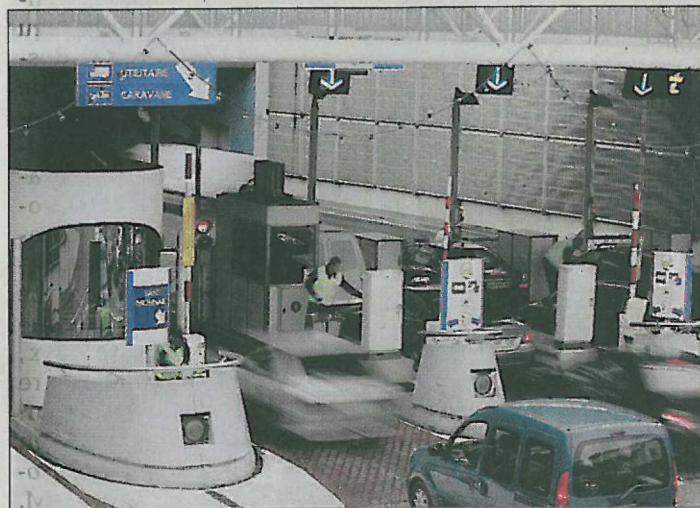
► La Société marseillaise du tunnel Prado Carénage (SMTPC) a connu une baisse de trafic de 3 % en 2008. / PHOTO CYRIL SOLLIER
